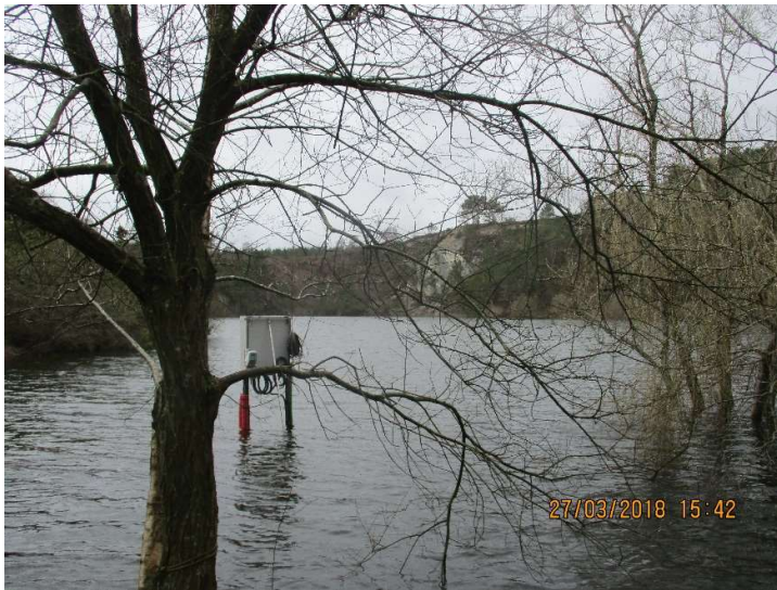
Figure 17 : Raccordement électriques des pompes et du compteur de la carrière Le Gallic
