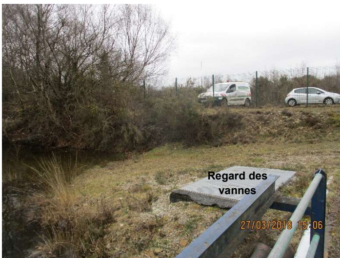
Figure 14 : Vue de l'ouvrage de vannage avec regard du plan d'eau Barazer
