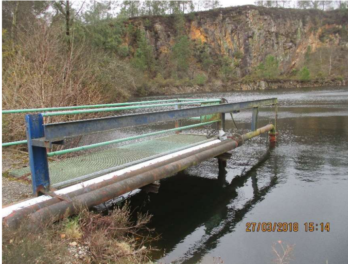
Figure 15 : Vue du ponton de prise d'eau de la carrière Barazer
