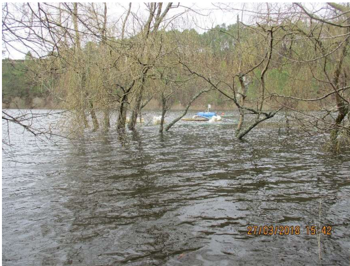
Figure 16 : Vue du ponton flottant des pompes immergées de la carrière Le Gallic
